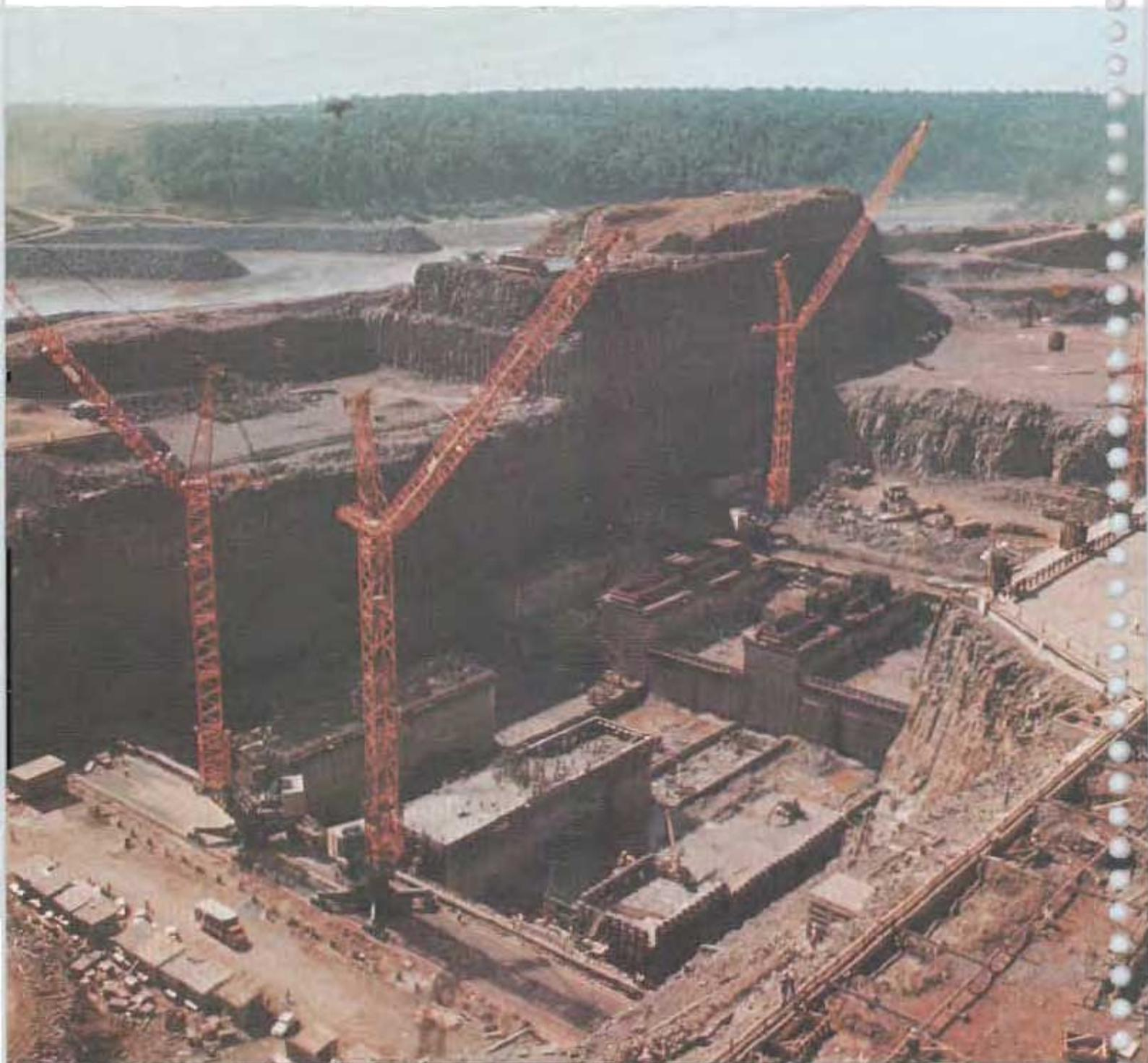
Vista de la situación de los trabajos de hormigonado de la estructura de desvío, parte integrante de la futura presa.
