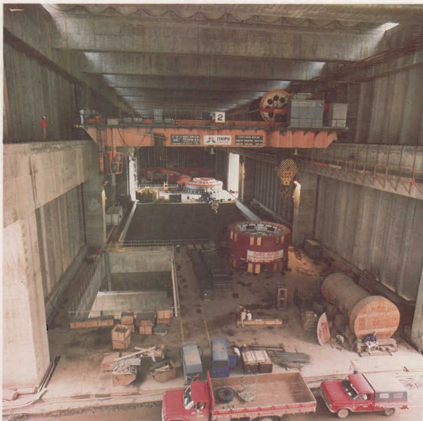
Edificio de descarga central en plena utilización.
