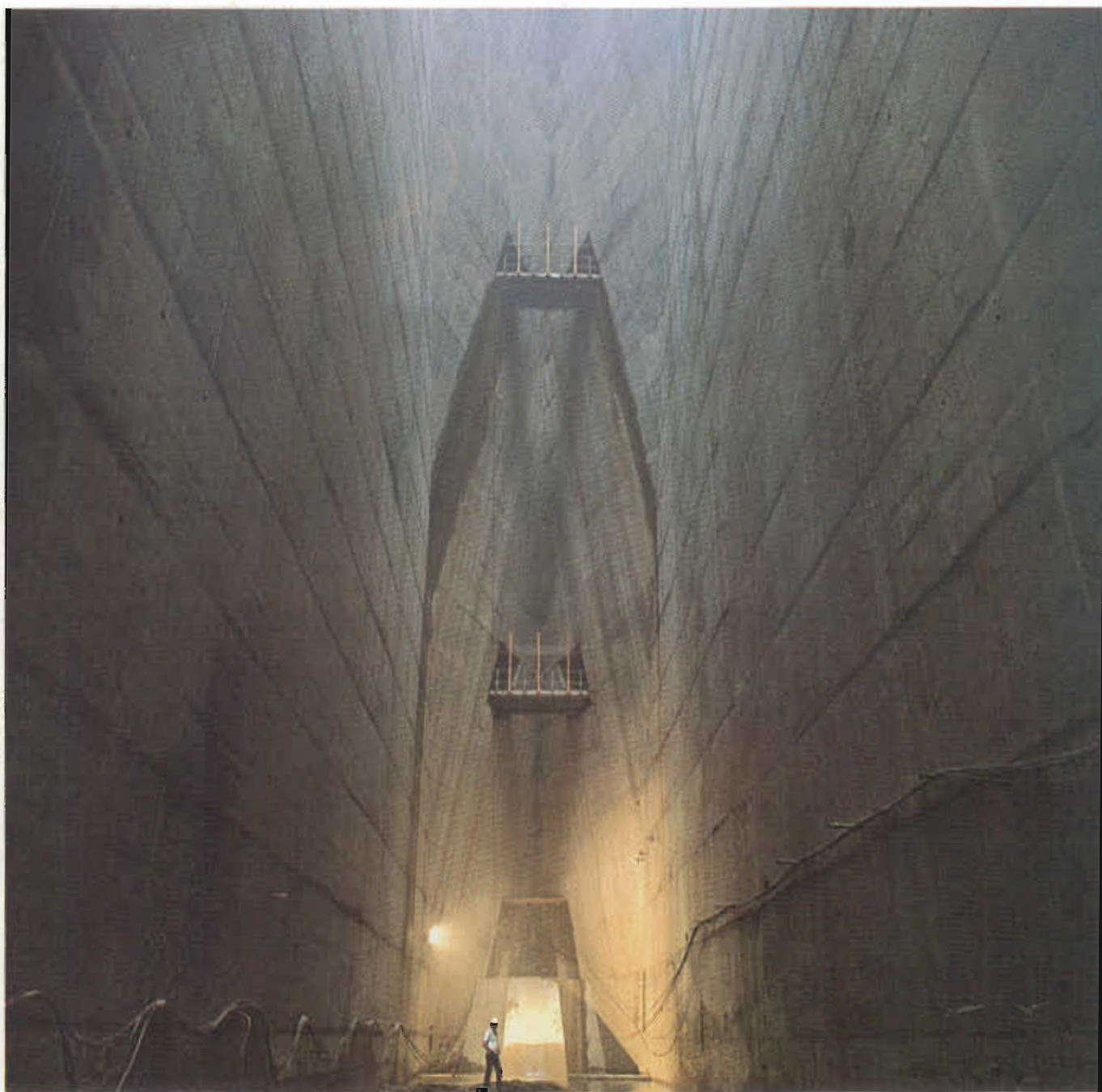
Interior de la presa principal de la central hidroeléctrica de Itaipú.
