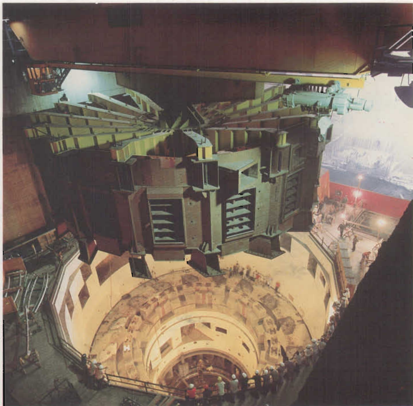
Descenso del estator de la unidad generadora nº 2 (50 Hz) al respectivo pozo, llevado a cabo en setiembre de 1982.
