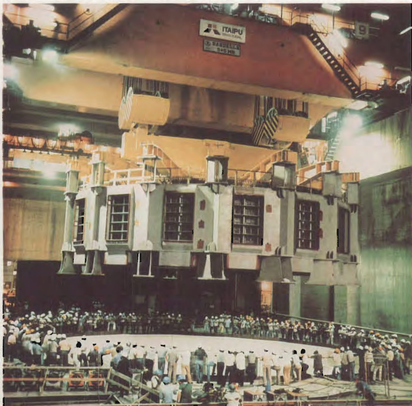
Descenso del estator (1.200 toneladas) de la unidad generadora (50 Hz) nº 1, al respectivo pozo, en el mes de abril de 1982.
