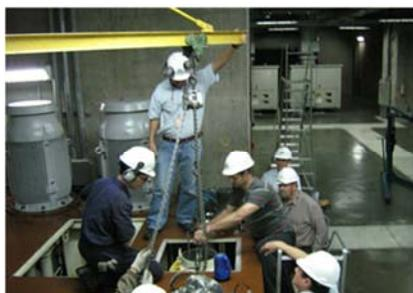
Desmontaje para reparación de la válvula distribuidora de la U18A, realizado por ITAIPU, bajo la supervisión y responsabilidad del CEITAIPU/Alstom.
