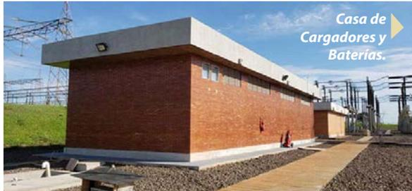
Fueron realizadas obras de construcción de la Casa de Cargadores y Baterías, local que albergará los Cargadores y Banco de Baterías de la Subestación Margen Derecha (SEMD). El proyecto ejecutivo para la instalación de los equipos fue finalizado en 2018, y la instalación está prevista para siguiente año.
