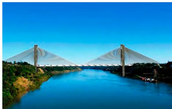
19,80 m de ancho. Contará con dos calzadas viales de 3,60 m de ancho cada una, y dos banquetas de 3 m a ambos lados, además de paseos peatonales en los dos extremos, de 1,70 m cada uno.
