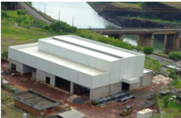
En 2019, se llevaron a cabo obras de construcción de la Unidad de Protección Anticorrosiva y Carpintería, destacándose la finalización de cierres laterales y de las estructuras prefabricadas y de cobertura.
