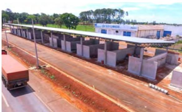
Las obras civiles contemplarán 124 puestos de ventas varias para los permisionarios, las divisorias correspondientes para hacerlo funcional y todo dentro de una arquitectura moderna, con una superficie total de 2.100 m<sup>2</sup> de área techada y acceso pavimentado con capacidad para alojar simultáneamente a 5 buses de 52 pasajeros.
