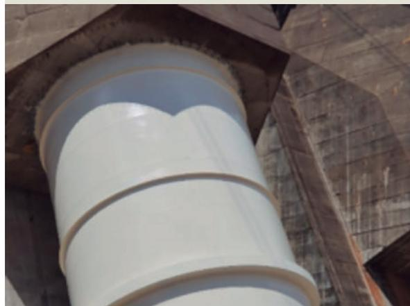
1.3.11 Conductos forzados luego de la aplicación de la protección anticorrosiva.
