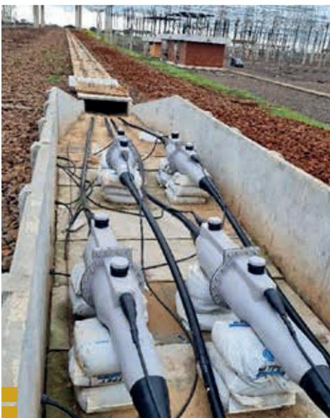
■ Nuevos conductores de 66 kV instalados.
