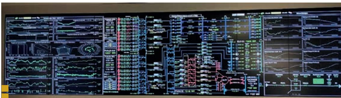
■ Videowall del Despacho de Carga con pantallas del *PI Vision* junto con pantallas del *SCADA/EMS*.
