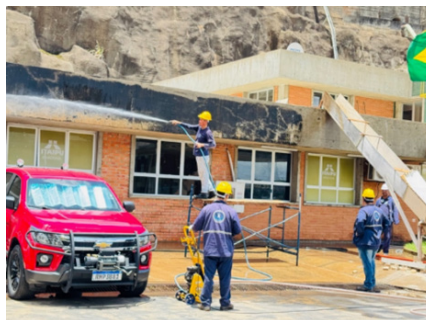
Edificio del Cuerpo de Bomberos de ITAIPU
