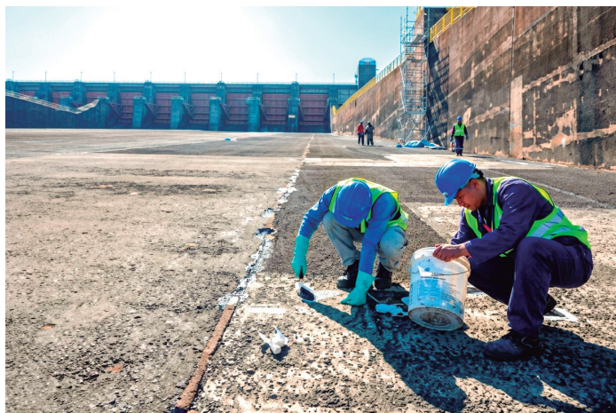
Trabajos en el vertedero de la CHI
