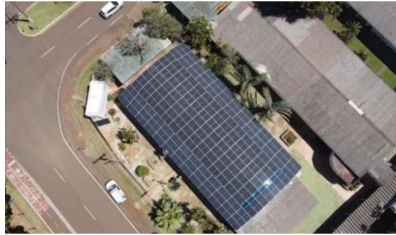
Sistema de generación solar autónomo
