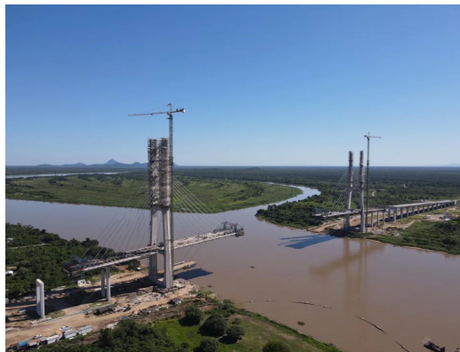
Obras en el Puente Internacional Bioceánico
