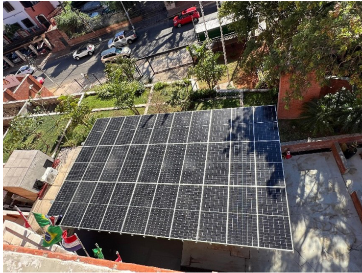
Techado solar fotovoltaico de inyección directa del edificio corporativo de la ITAIPU Binacional
