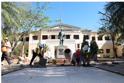
Obras en el CNC
