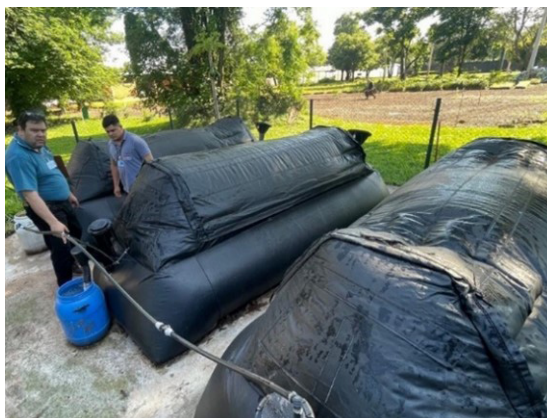
Mantenimiento preventivo y correctivo de termocalefones solares
