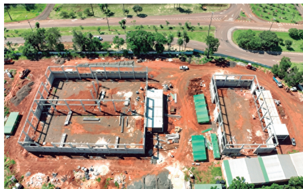
Vista aérea de la construcción de los almacenes de la margen paraguaya
