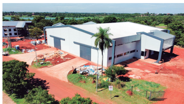
Obras en el Centro TASK
