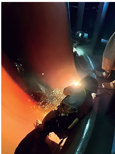
Reparaciones de cavitación de las unidades generadoras
