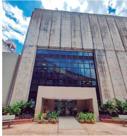
Edificio de mantenimiento – cota 144
