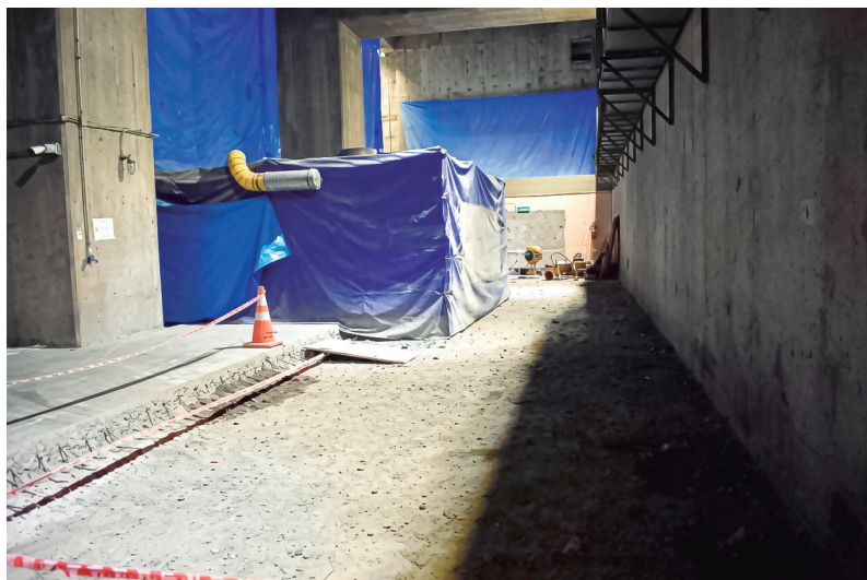
Espacio para la futura instalación del SFC – demolición del piso
