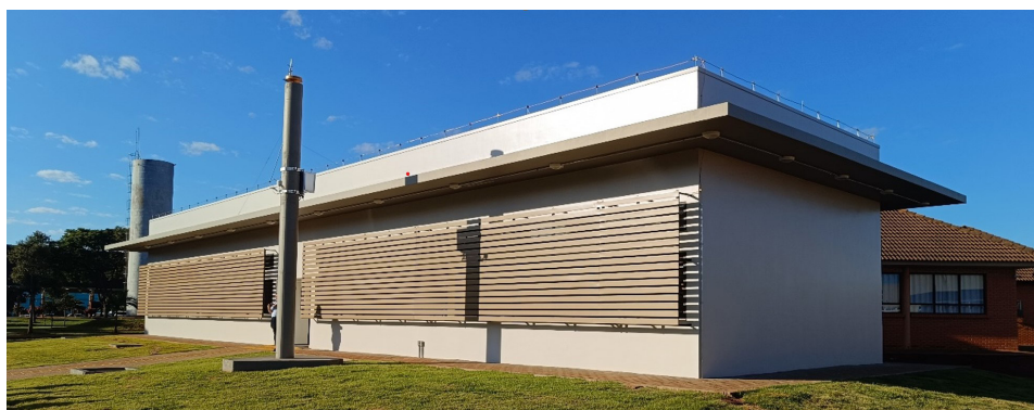
Edificio con laboratorios, aulas y pilar de monitoreo geodésico construido con recursos del convenio
