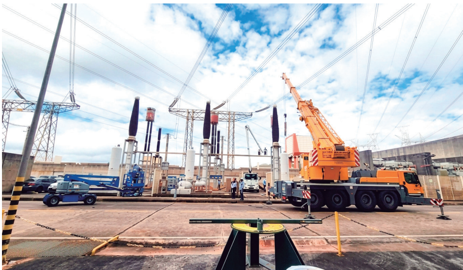
Retiro e instalación de nuevos equipamientos
