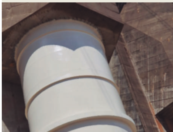
1.3.11 Condutos após a aplicação da proteção anticorrosiva.
