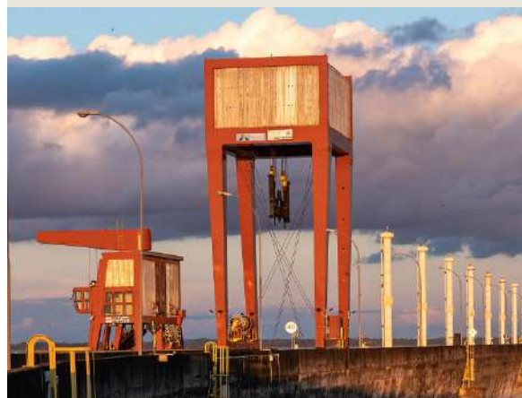
1.3.4 Pórtico com nova proteção anticorrosiva.
