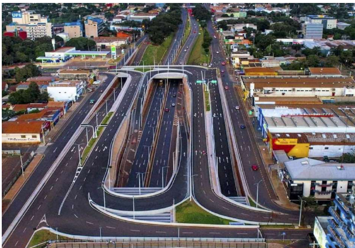
Multi-viaduto Km. sete de Cidade de Leste.
