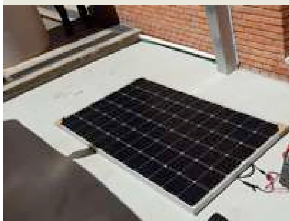
Início das provas dos painéis solares.
