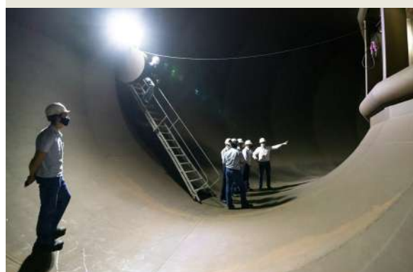
1.3.19 Novas luminárias e dispositivos para a iluminação temporária das Unidades Geradoras.
