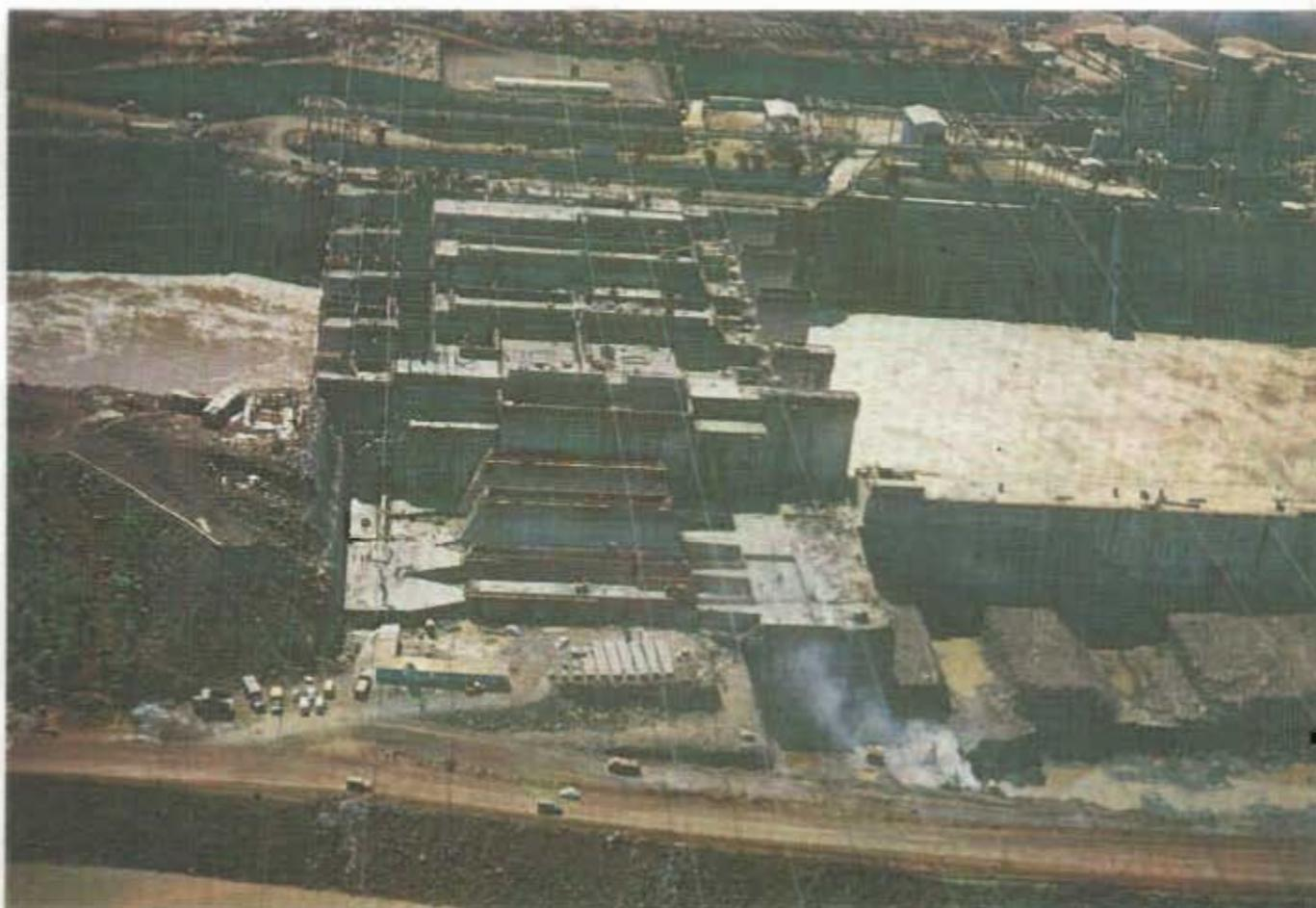
**Obras de Hormigonado de la Central Hidroeléctrica — La Prosecución de la Construcción de la Estructura de Desvío y el Inicio de la Construcción de los Bloques F 35/36 y F 33/34 de la Presa Principal.**
