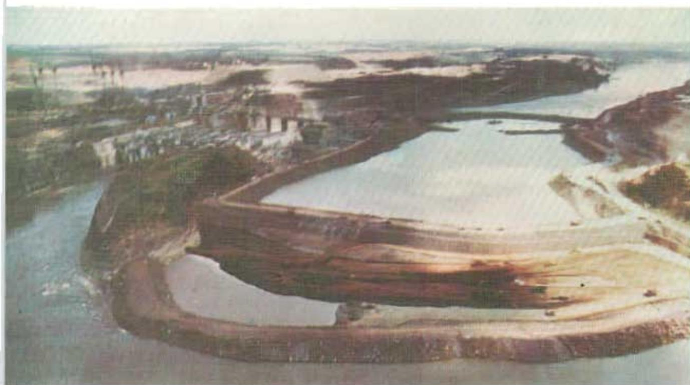
**Operaciones de Impermeabilización de las Ataguías de Aguas Arriba y los Trabajos de Hormigonado en Varios Frentes de la Central Hidroeléctrica.**
