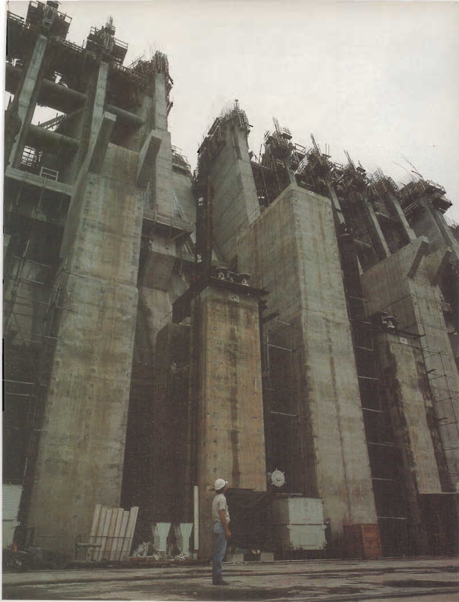
Una vista del montaje de las compuertas de la estructura de desvío.
