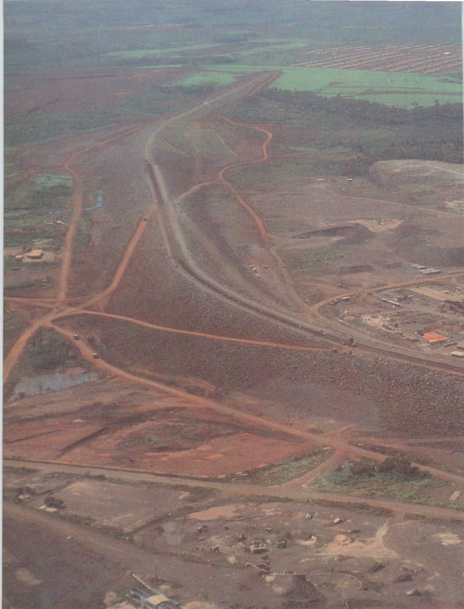
Una visión de las presas de enrocado y de tierra izquierda de la central de itaipú, prácticamente concluidas.
