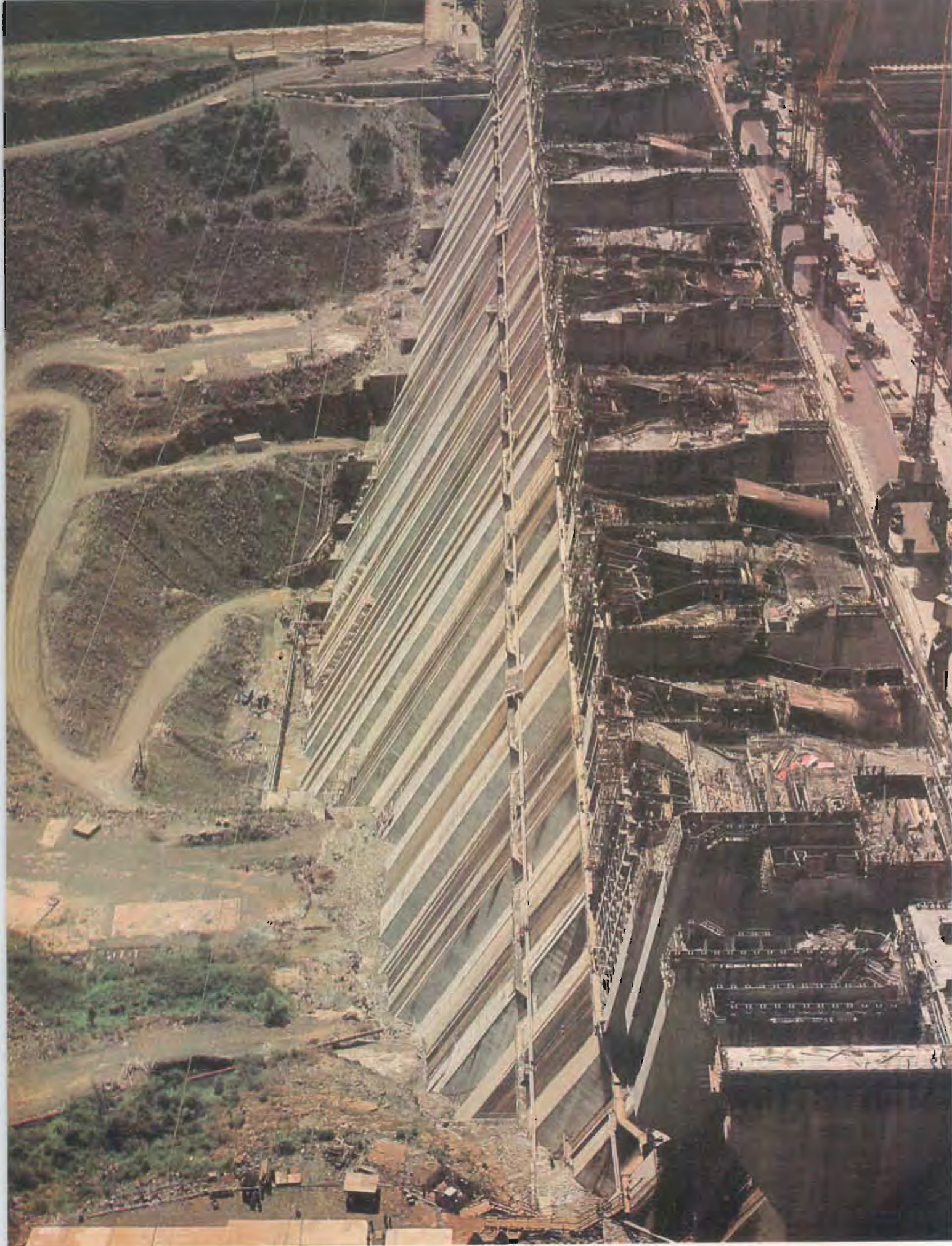
Otra vista de la presa principal de la central de Itaipú, tomada desde aguas arriba, viéndose el espacio que será objeto de la denominada operación de precarga, en el inicio de 1982.
