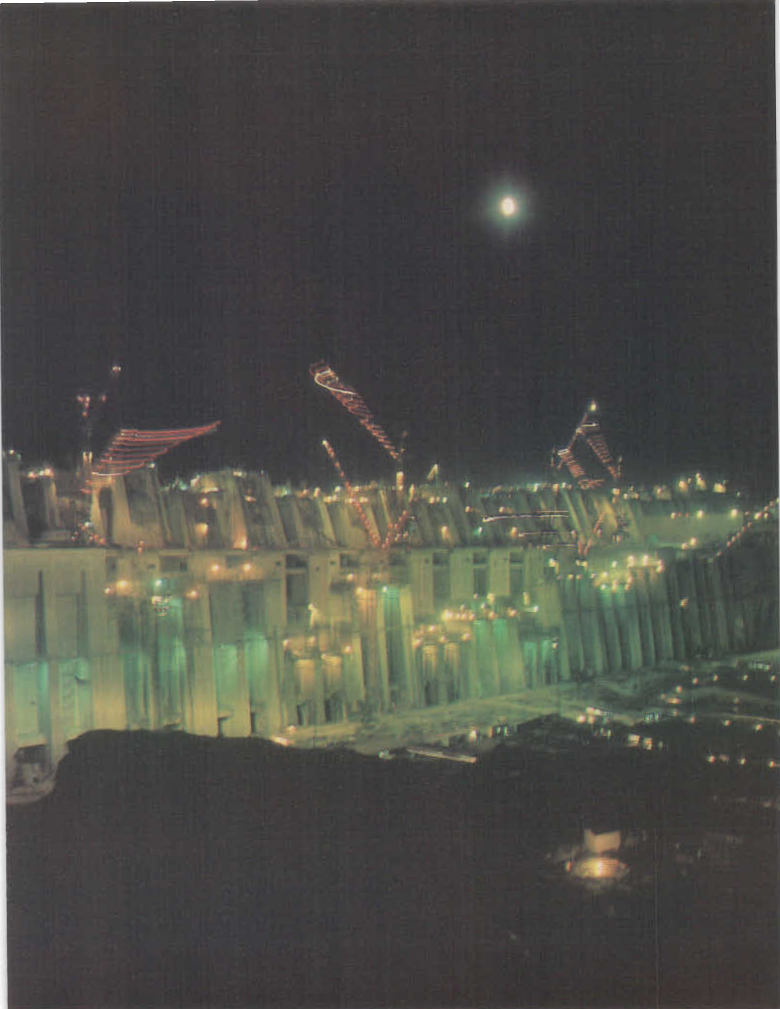
Una vista general, tomada desde aguas abajo, que muestra el estado en que se encuentra la construcción de la casa de máquinas de la central de Itaipú, en su trecho en el antiguo lecho del río Paraná. Al fondo se ve la presa principal.
