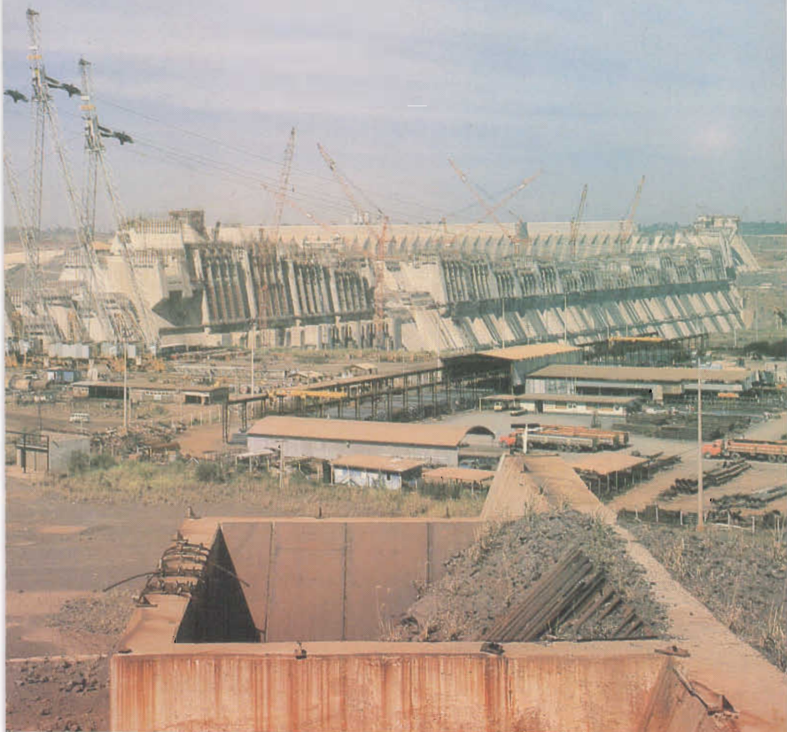
Una vista de la toma de agua de aguas arriba, de la presa principal de la central de Itaipú, viéndose en su tope los locales para las tomas de agua, ya en fase final de construcción.
