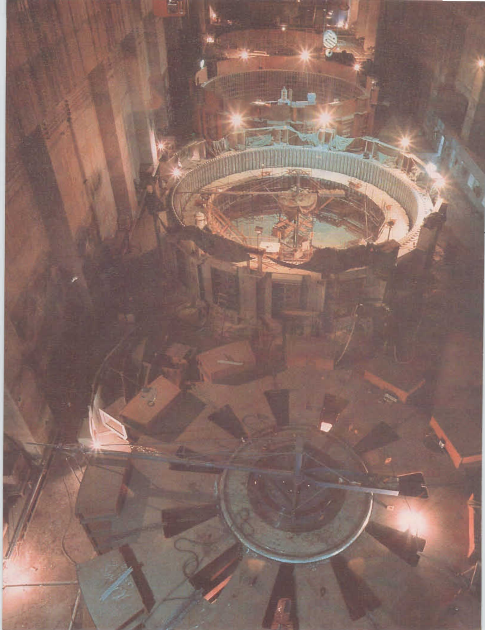
Una vista del área de montaje derecho, en plena utilización en los trabajos de montaje de componentes de las unidades generadoras n° 1, n° 2 y n° 3, en el extremo derecho de la casa de máquinas, en su trecho en el antiguo lecho del río Paraná.
