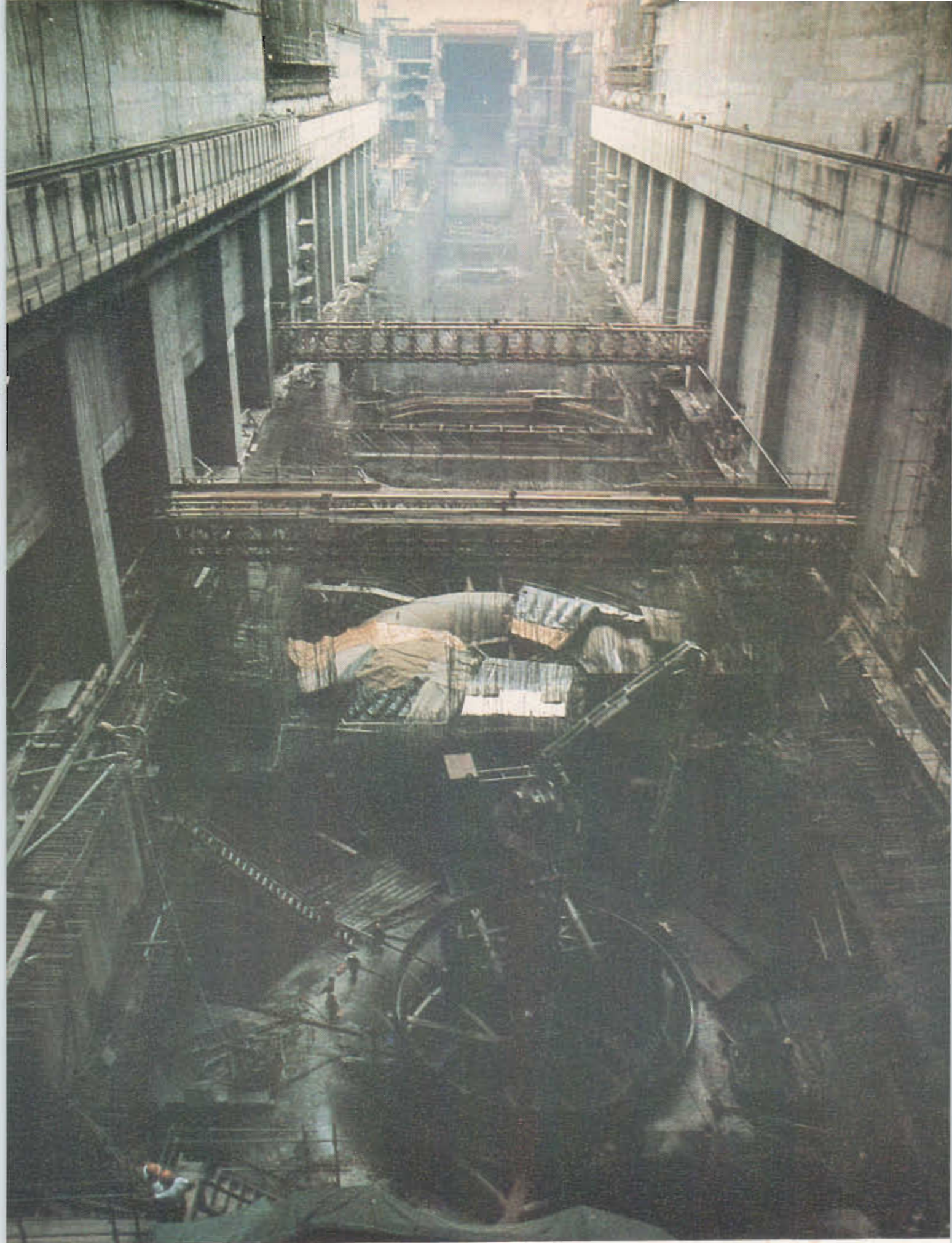
Otra vista de la construcción de la casa de máquinas de la central de Itaipú, en su trecho en el antiguo lecho del río Paraná.
