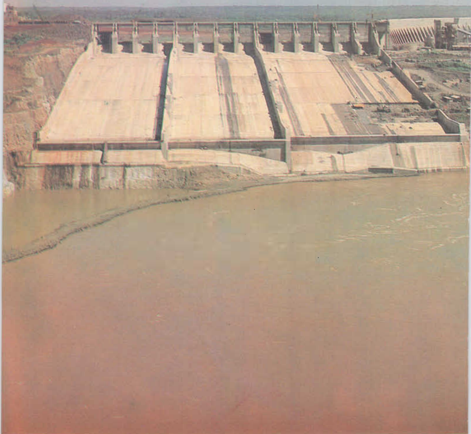
Una vista del estado en que se encuentra la construcción de las canaletas del vertedero, prácticamente concluidas.
