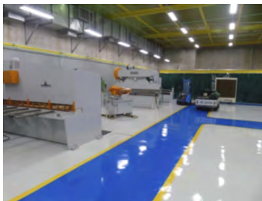
Calderería después de la reforma.
