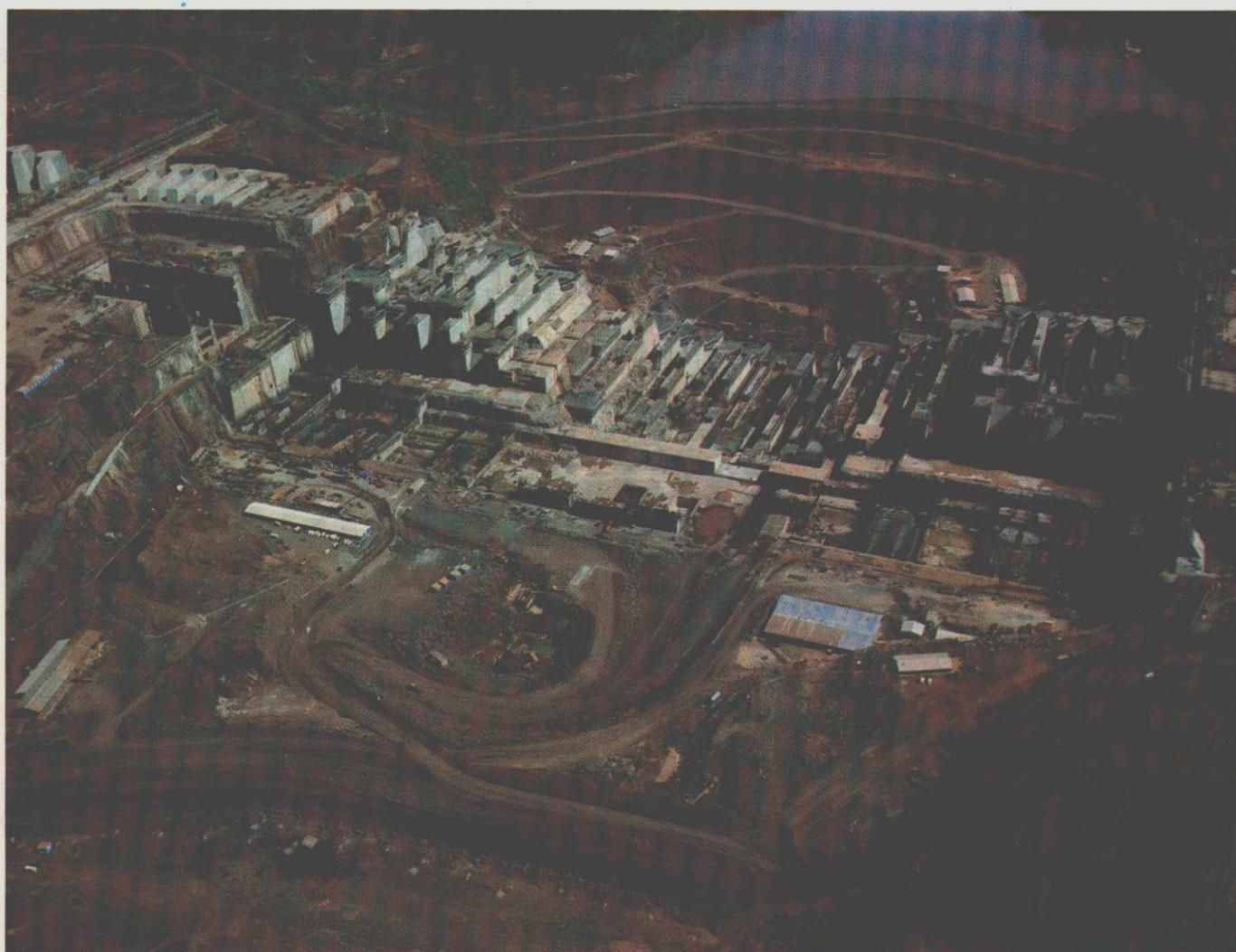
Vista setorial da situação dos trabalhos de construção de Itaipu, ao término de 1979, vendo-se a concretagem da barragem principal e da casa de força, no antigo leito do Rio Paraná.
