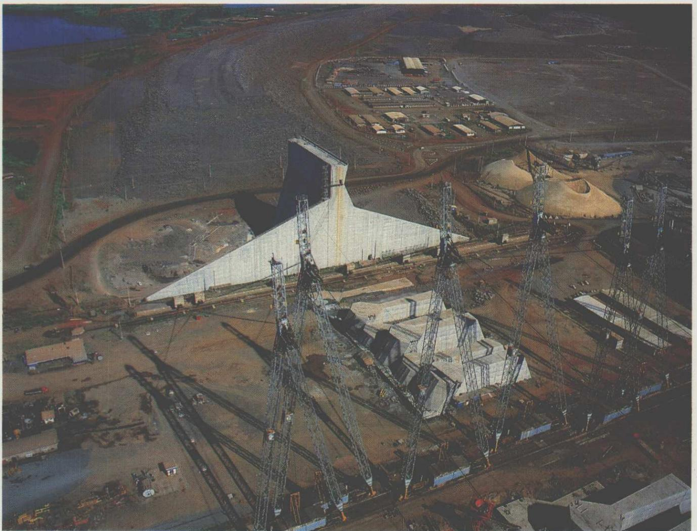
Vista setorial da situação dos trabalhos de construção de Itaipu, ao término de 1979, focalizando a barragem de enrocamento, praticamente concluída, vendo-se, em primeiro plano, as obras de sua ligação com a barragem principal.
