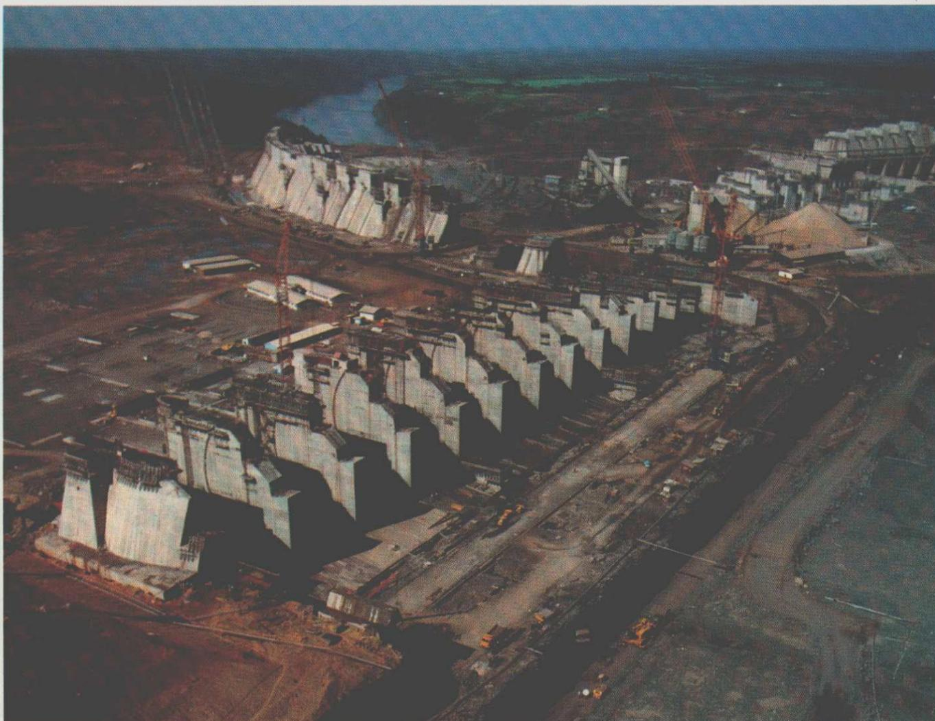
Vista setorial da situação dos trabalhos da construção da central hidrelétrica, ao término de 1979, vendo-se o avançado estágio da concretagem da crista do vertedouro.
