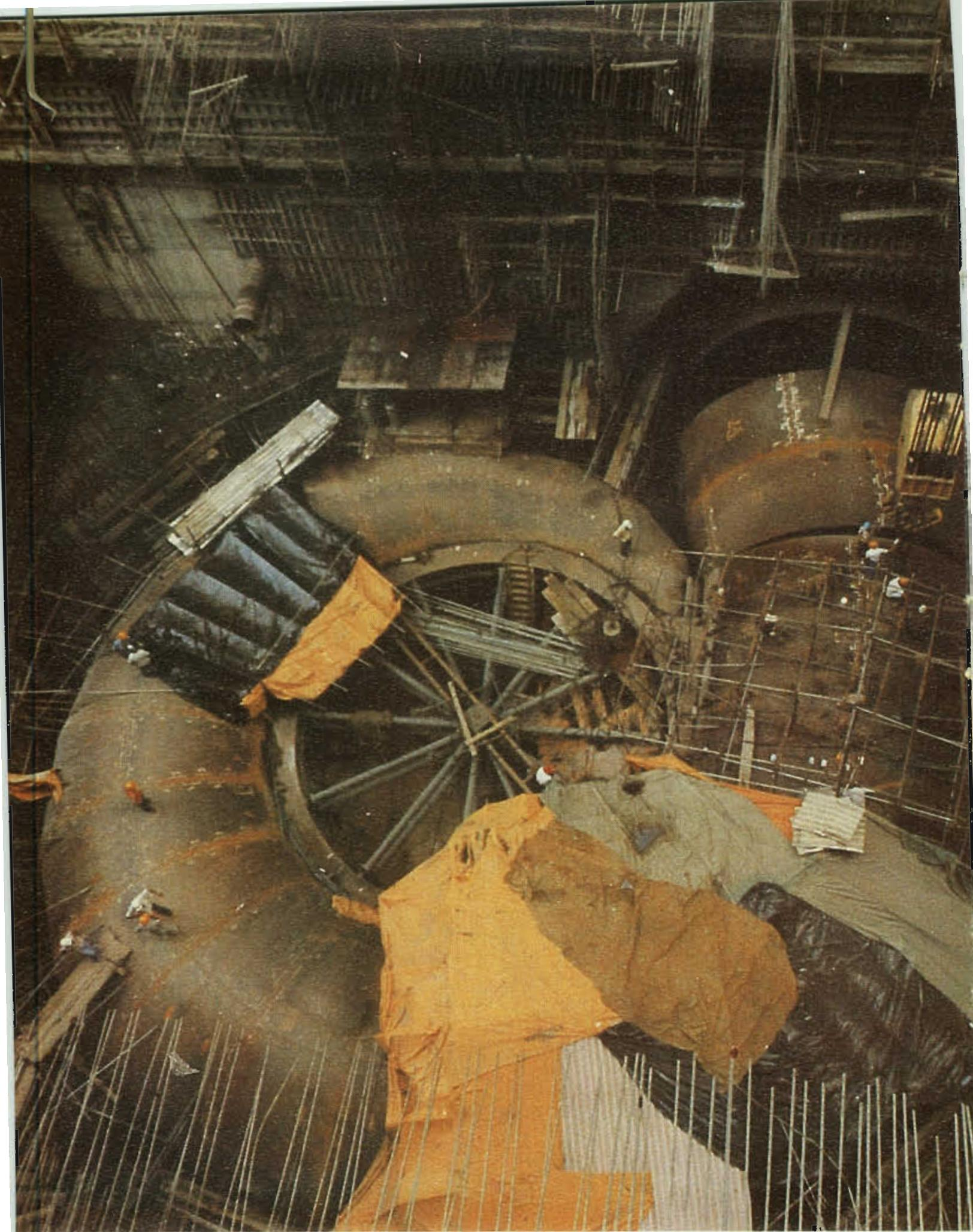
Visão da montagem da unidade geradora n.º 14, na parte referente à turbina, estando em instalação a caixa espiral.
