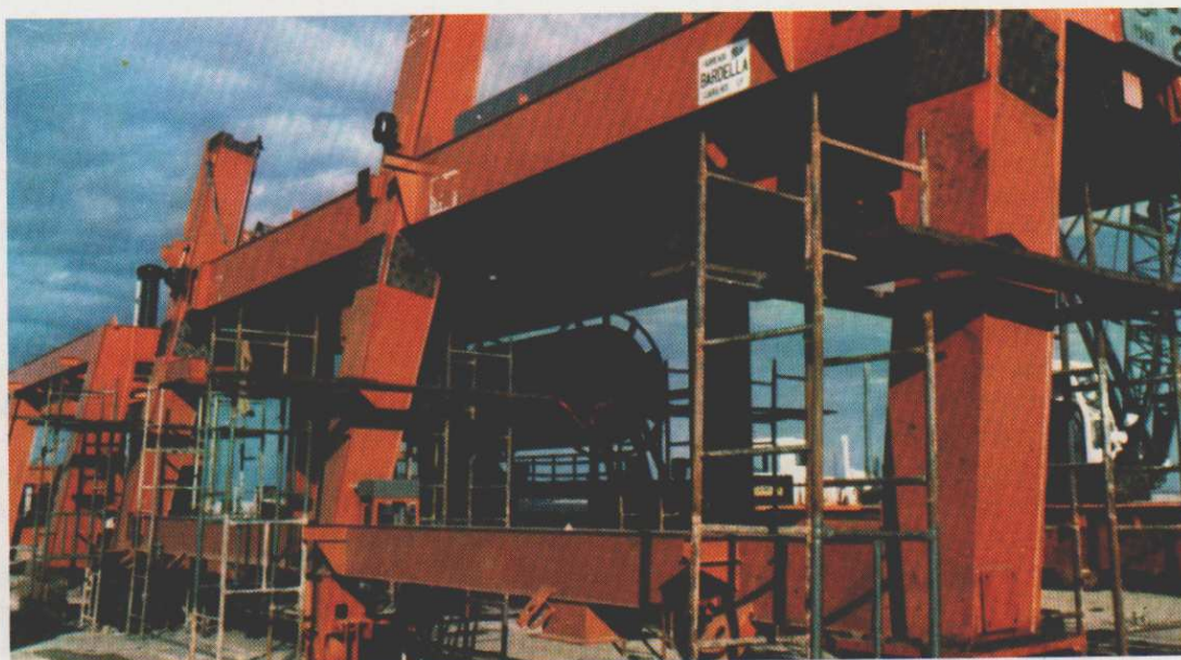
Guindaste limpa grades n.º 1 em montagem.
