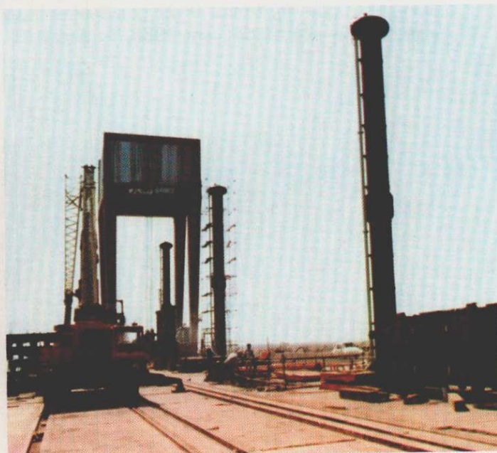
Servo-motores das tomadas d'água n.º 1 e n.º 2 em montagem.
