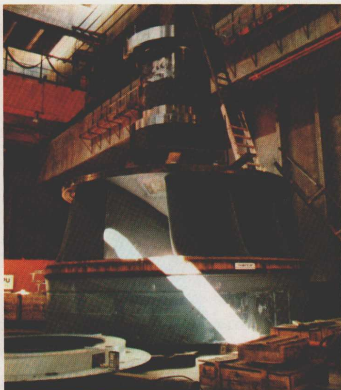
A roda e respectivo eixo de uma das turbinas sendo acoplados na Central de Itaipu.
