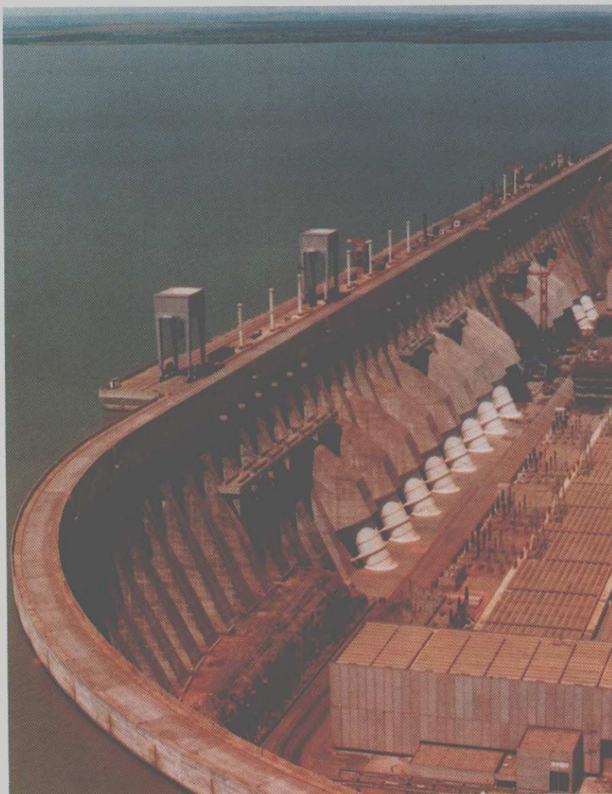
A Central Hidrelétrica de Itaipu. Em operação nove unidades geradoras, ou seja, 50% do total previsto para a casa de força. Em estágios diversos de montagem, oito máquinas, com previsão de término no triênio 1988/89/90.
