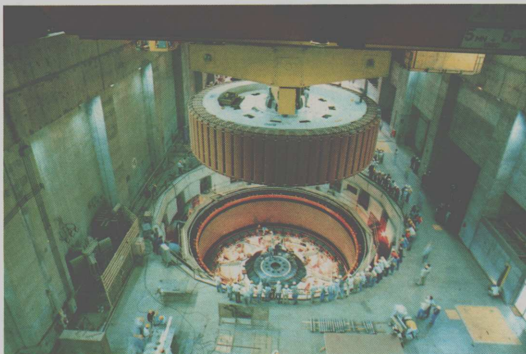
Descida do rotor da unidade geradora n° 8 (50 Hertz) - ocorrida a 08.09.87.
