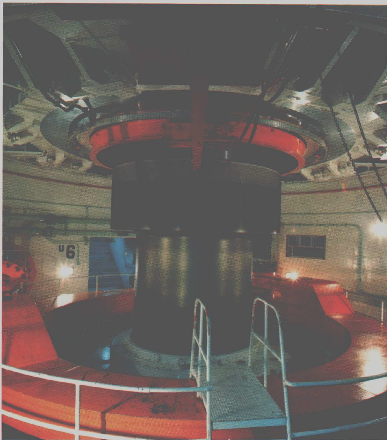
Primeiro giro mecânico da unidade geradora n° 6 (50 Hertz) - ocorrido em 26.06.87.
