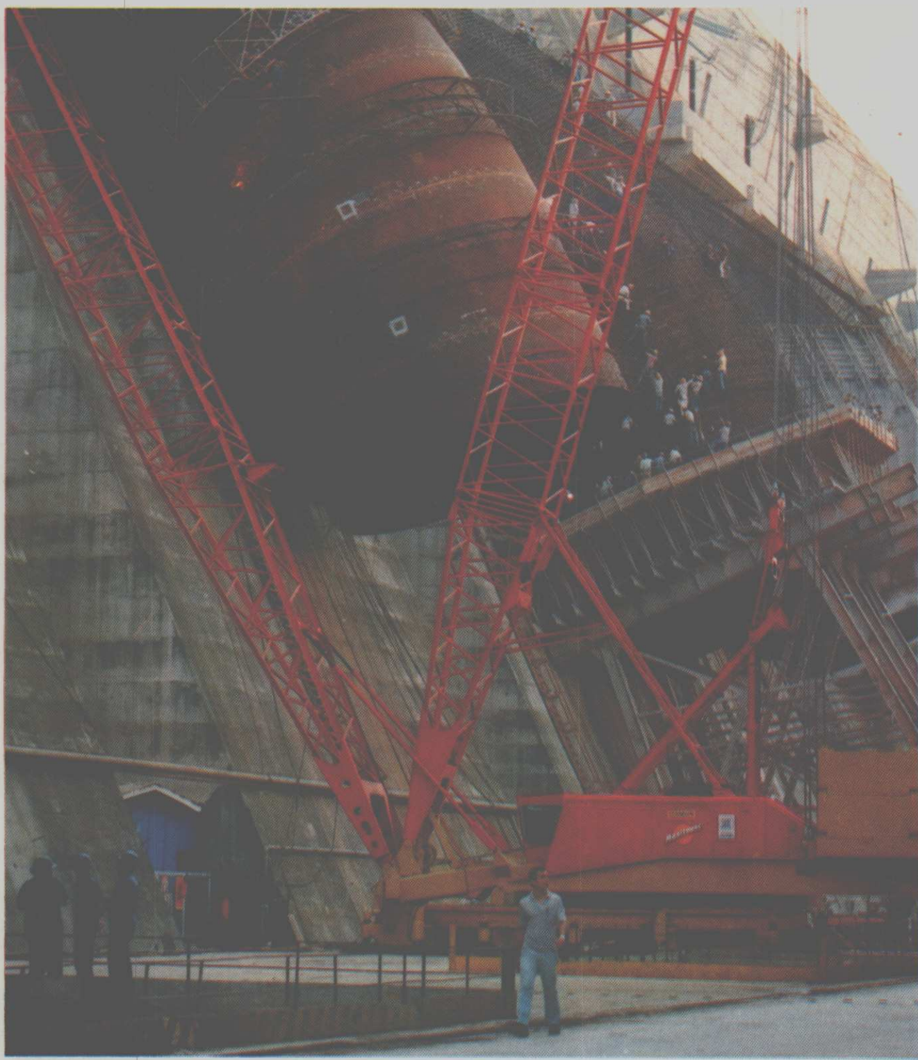
Trabalhos de instalação de um dos condutos forçados, em 1987.
