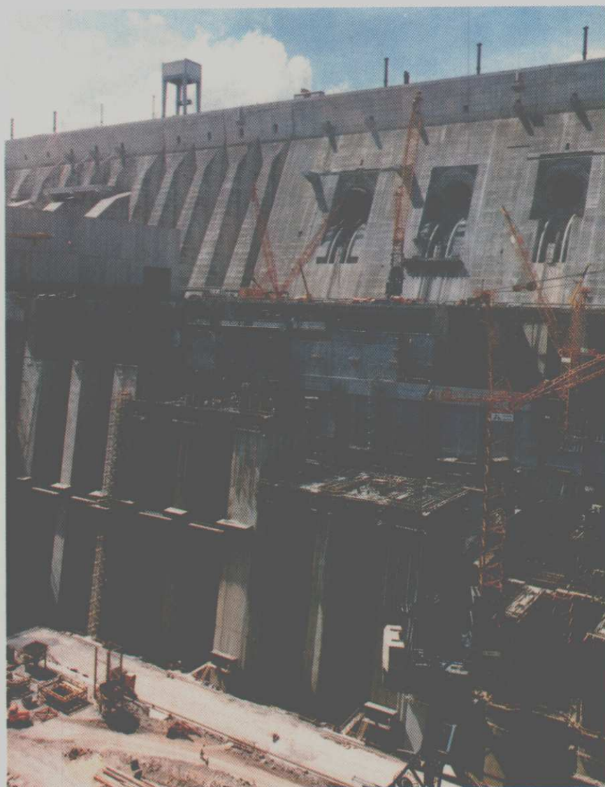
Situação da concretagem, da casa de força da central hidrelétrica de Itaipu, no trecho do antigo canal de desvio — unidades geradoras N o s 16, 17 e 18, todas de 60 Hertz.
