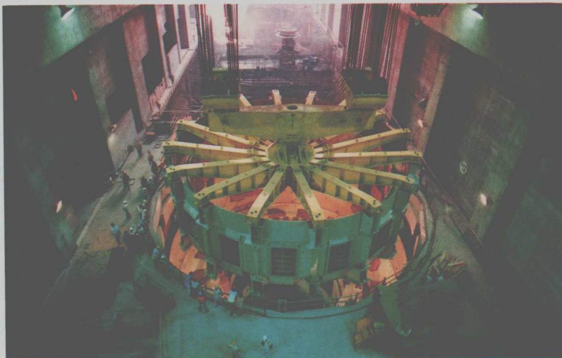
Descida do estator da unidade geradora nº 13 (60 Hertz) - ocorrida a 23.02.87.
