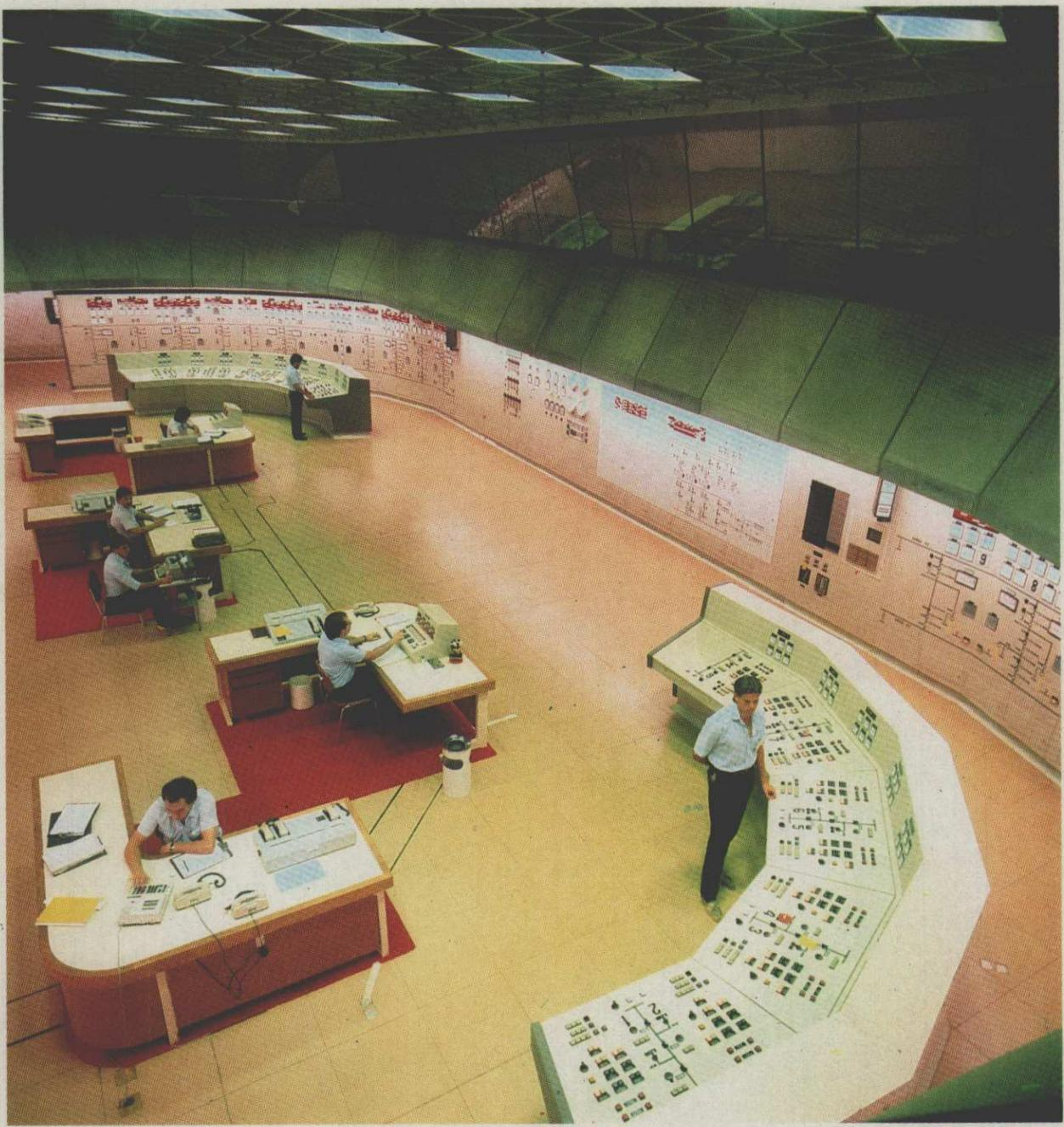
No decorrer de 1988, a operação das unidades geradoras em funcionamento, tanto as de 50 Hz, como as de 60 Hz, passou a ser controlada desde a sala de comando centralizado da casa de força.
