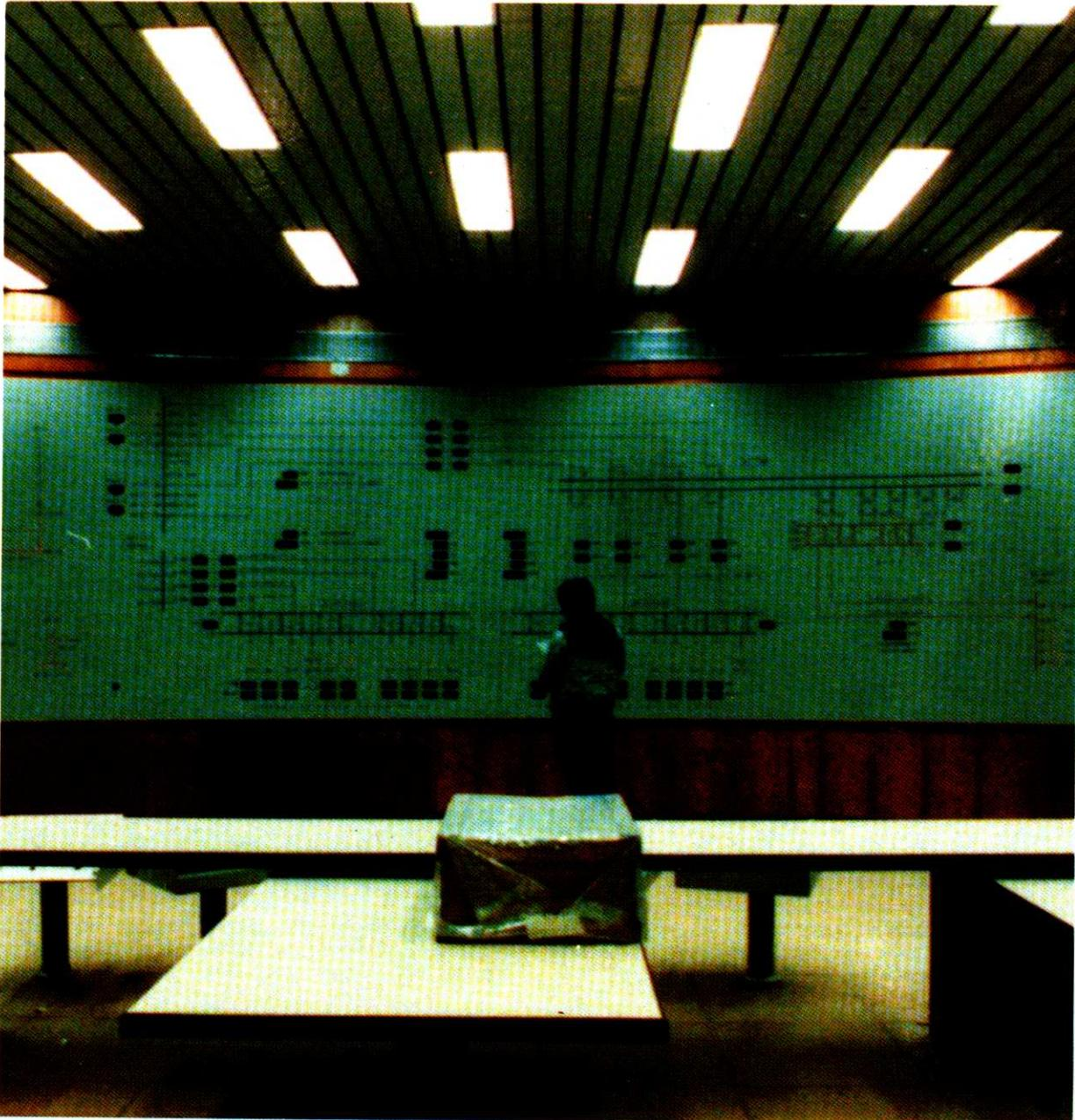
A sala de despacho de carga, em fase final de instalação (foto) situada no edifício de operação, constitui o último elo na cadeia que envolve a produção, a operação e a entrega da energia produzida em Itaipu aos sistemas elétricos da ANDE e da ELETROBRÁS (FURNAS), a qual responde pela eficiência no fornecimento de eletricidade em atendimento aos contratos de compra e venda firmados entre a Entidade Binacional e aquelas entidades, e portanto, pelo ingresso da receita financeira da Itaipu.
