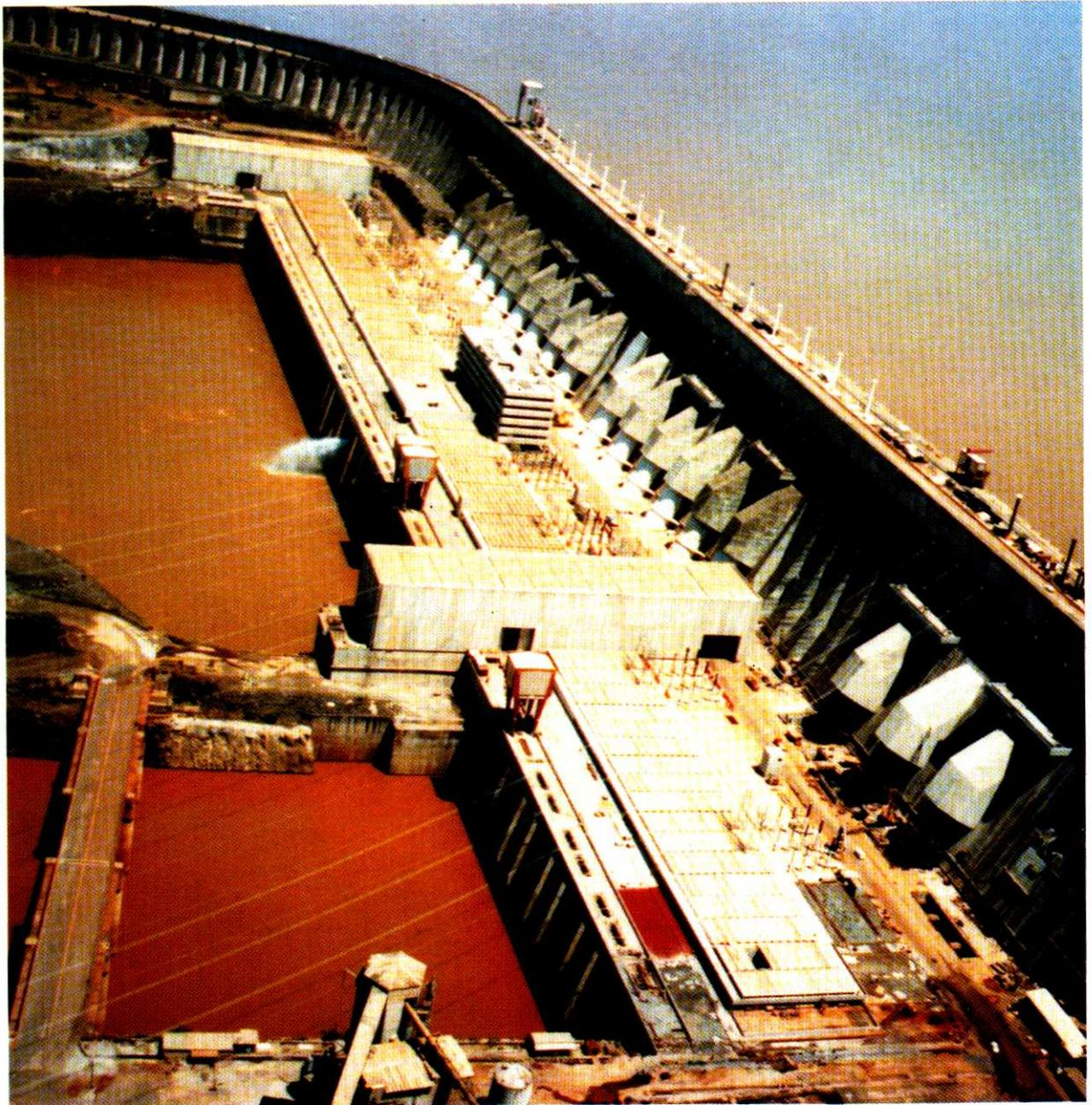
A fotografia registra a situação praticamente concluída dos 18 condutos forçados da casa de força de Itaipu, inclusive no trecho do canal de desvio.
