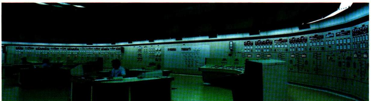
Encontra-se em fase final de construção e de instalação o edifício de operação da usina de Itaipu, o qual está situado na parte central externa da casa de força, onde funcionarão todos os órgãos técnicos ligados à produção, operação, à coordenação e ao despacho da energia elétrica; as três fotos indicam sucessivamente: visão externa, hall de entrada e a sala de comando centralizado.
