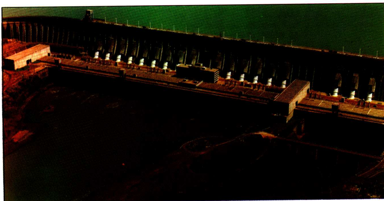
Vista parcial da Usina
