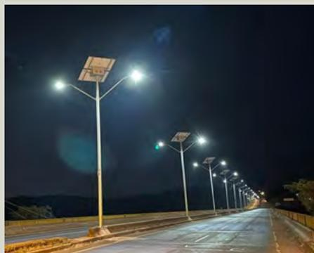
Este projeto piloto melhorou a iluminação viária, a eficiência energética, a segurança no trânsito e os custos associados ao consumo de energia elétrica, evitando também o roubo recorrente de cabos e o desgaste dos equipamentos. A verificação da iluminação viária foi feita através de uma malha com 60 pontos de medição fotométrica entre colunas, atendendo às normas internacionais.
