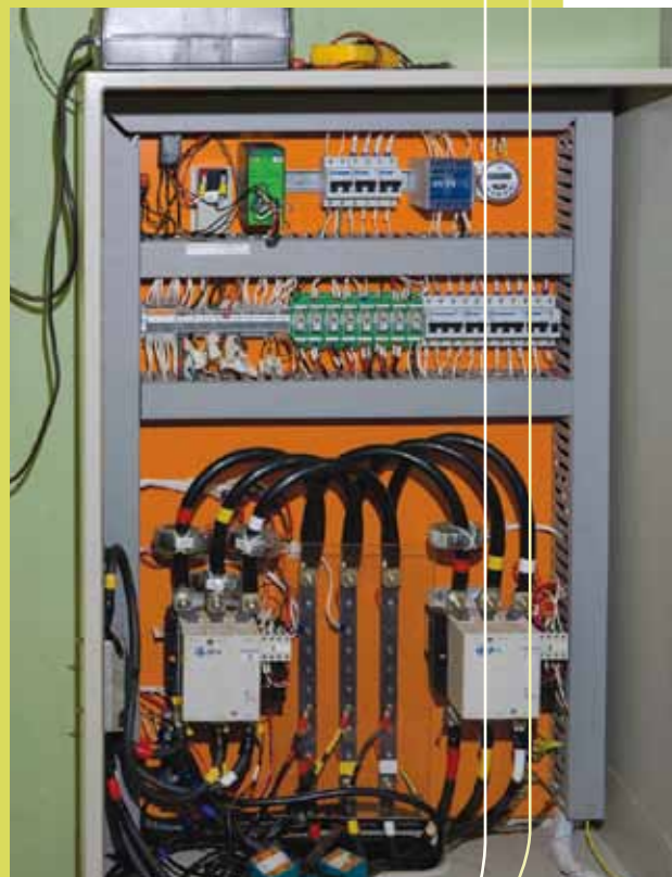
Painel de comando para ligação da geração distribuída à rede interligada da Copel.
