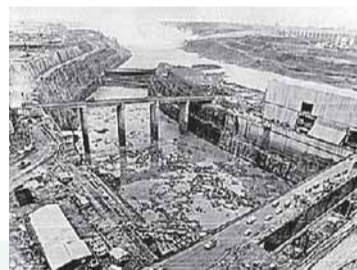
Desvio do rio (1977) Um dos momentos mais críticos do projeto foi a mudança no fluxo do poderoso Rio Paraná para a construção da barragem.
