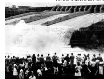
Funcionamento (11/1982) O vertedouro, com uma vazão equivalente a 40 Cataratas do Iguaçu, foi aberto no dia 5 e inaugurou oficialmente a usina.
