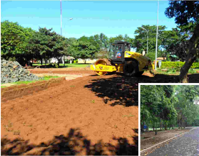
Construcción de pavimento tipo empedrado.
