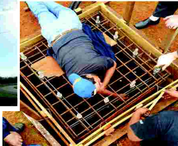
Servicio de construcción de base para mástil en el acceso al Refugio Biológico Tatí Yupí.
