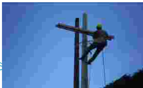
Sustitución de columnas de hormigón en Tatí Yupí.
